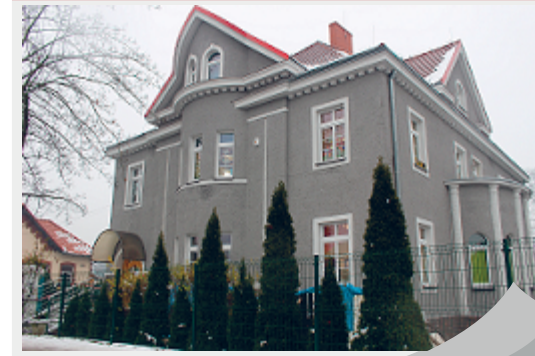
REMONTY W PRZEDSZKOLACH
