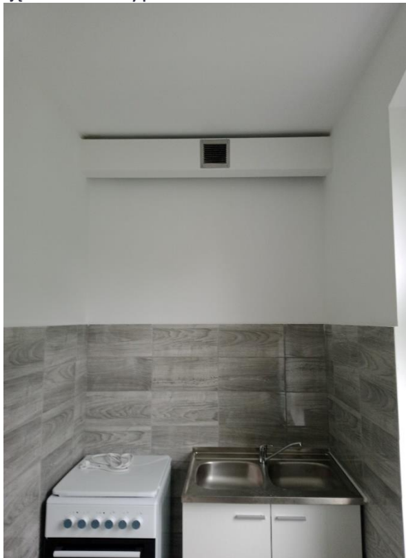
Zdjęcie 5. Pustostany po remoncie
