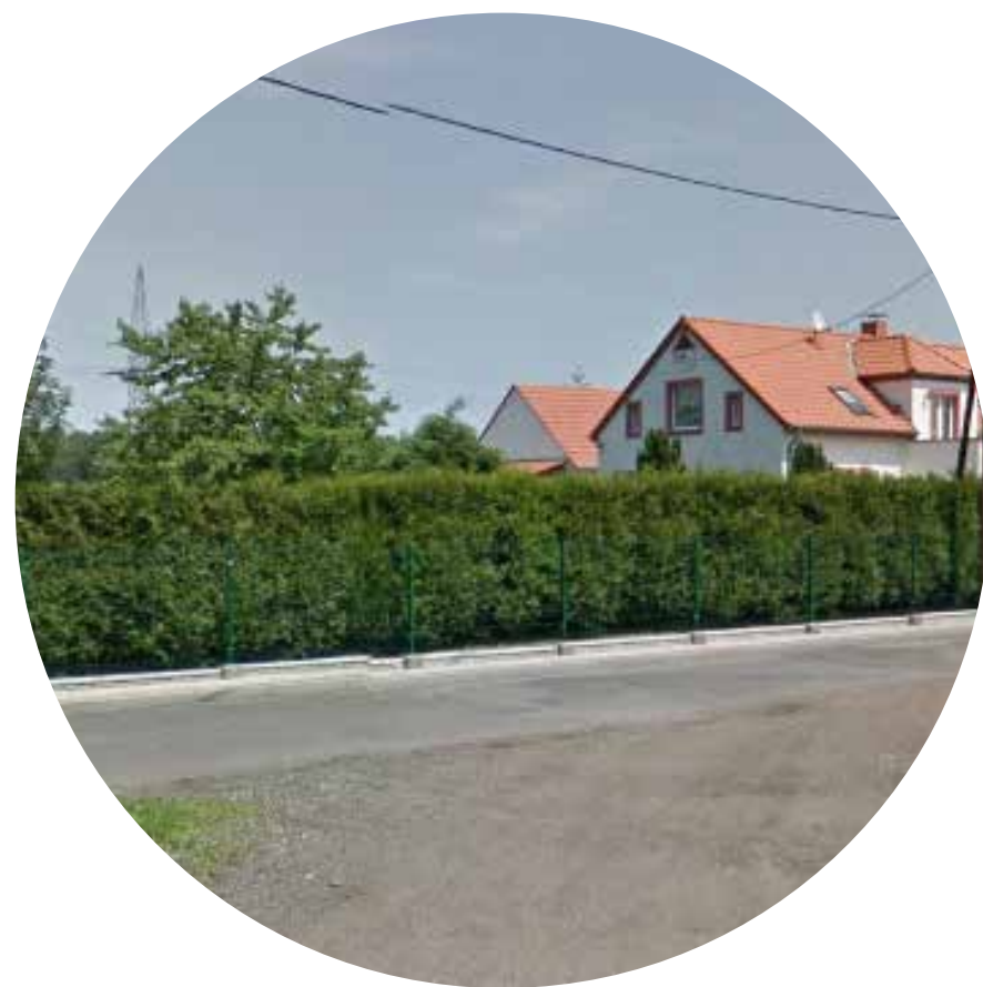
Utwardzenie drogi w Lenartowicach
